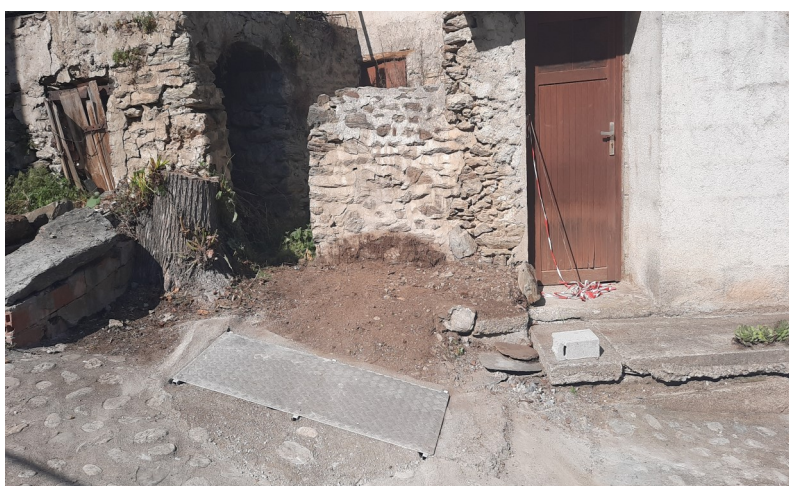
Après les travaux
